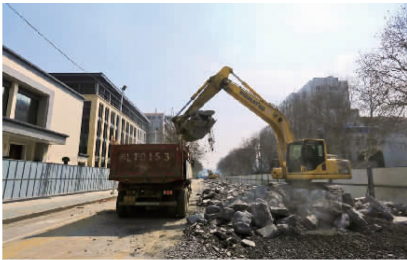
解放路 开始施工
