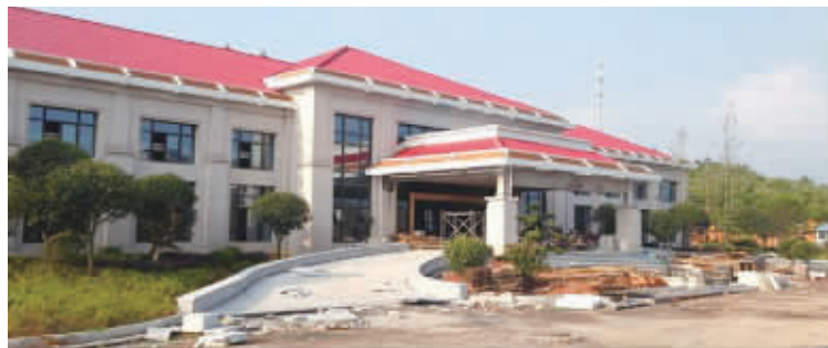
接待中心外正在进行装修扫尾工作
