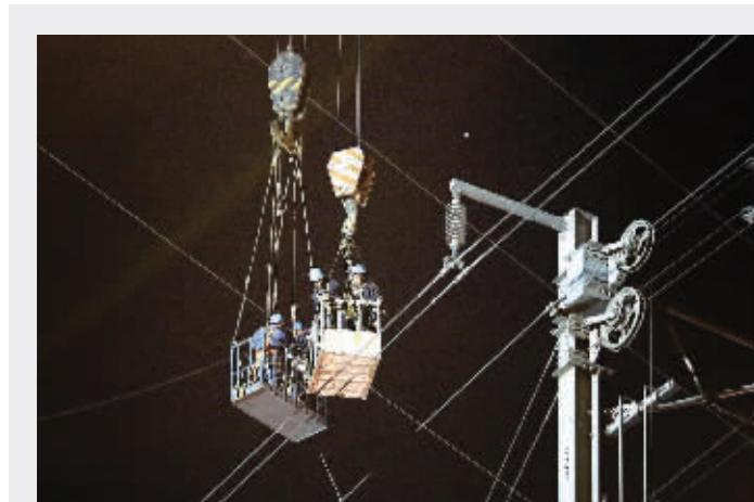
昨日凌晨，镇江市供电公司职工在距地面20米高空对横跨京沪高铁上方的导地线进行拆除。为不影响高铁运营，当日零时，市供电公司施工人员连夜对润兴路跨越京沪高铁的110千伏的线路进行拆除，以配合我市润兴路改造工程的顺利施工。
