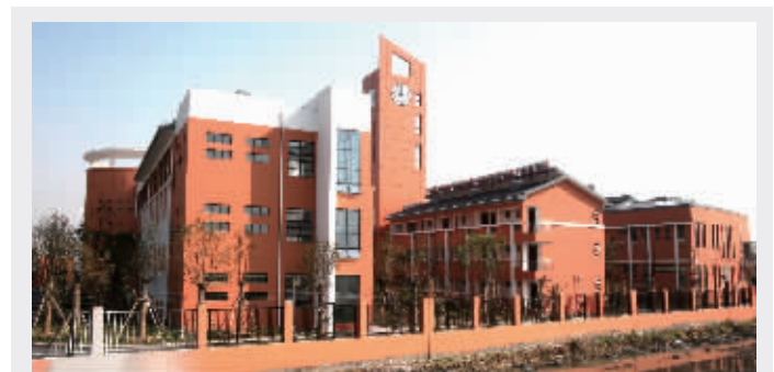
昨天，建筑总面积达19600平方米的镇江新区姚桥小学易地重建完工。新校区布局合理、外形美观，教学、生活、活动区相对分开。校舍达到八级抗震要求，基本设施配备到位。
