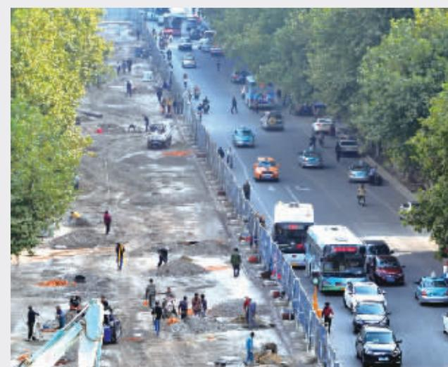
昨天,解放路改造道路西侧施工基本完成,计划本月底完成大市口至万古一人路段东侧沥青底层摊铺,万古一人路至长江路段东侧雨水管道及供电管道施工。
