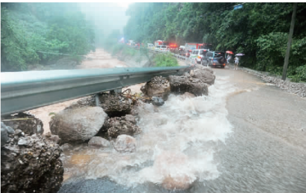
通往都江堰中兴镇三溪村的道路被山洪淹没(7月10日摄)。
